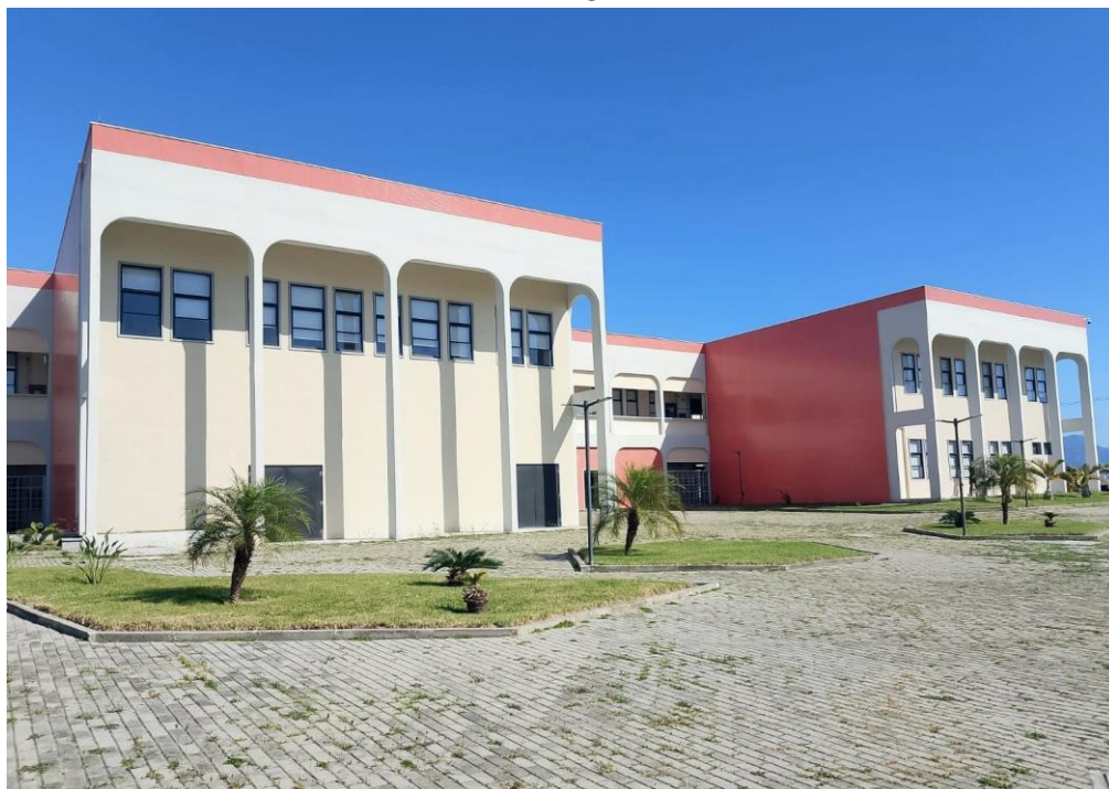
Legenda: Instalação do Instituto de Arte e Comunicação Social (IACS) – local do evento.
